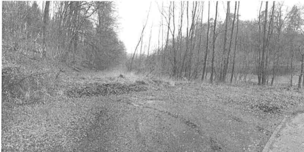
Abbildung 1 – Standort für die Errichtung des Nachklärbeckens
