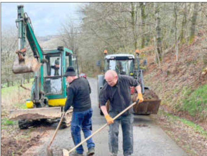
Durch den Starkregen war der Straßenrand sehr ausgespült. Dadurch bestand die Gefahr, dass die Fahrbahn unterspült wird und größerer Schaden entstehen könnte. Deshalb wurde mit dem Bagger der Randstreifen ausgehoben, wieder mit Schotter verfüllt und danach verdichtet. Auch mit der Herstellung von seitlichen Wasserabläufen wurde dafür gesorgt, dass das Regenwasser an mehreren Stellen wieder ungehindert abfließen kann.
